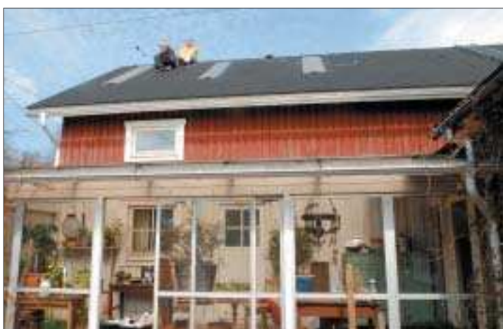
Bränner fast. Vivo Kudinov och Thomas Hartvik fäster hållare för solfångare på filttaket.
