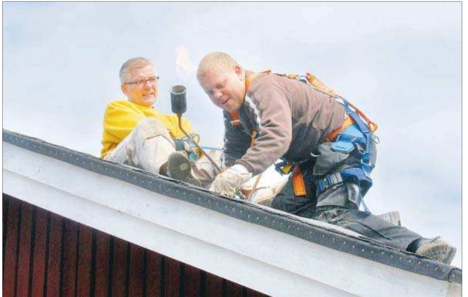
Hett jobb. Vivo Kudinov (till höger) bränner fast solfångarfundament på Aslög Granlids hustak. Thomas Hartvik assisterar.
