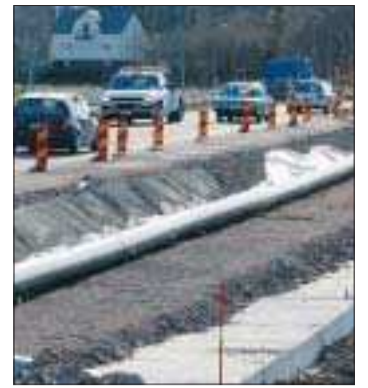
När gjutningsarbetet tar vid blir Sviby bro helt avstängd en tid. Foto: ERKKI SANTAMALA
