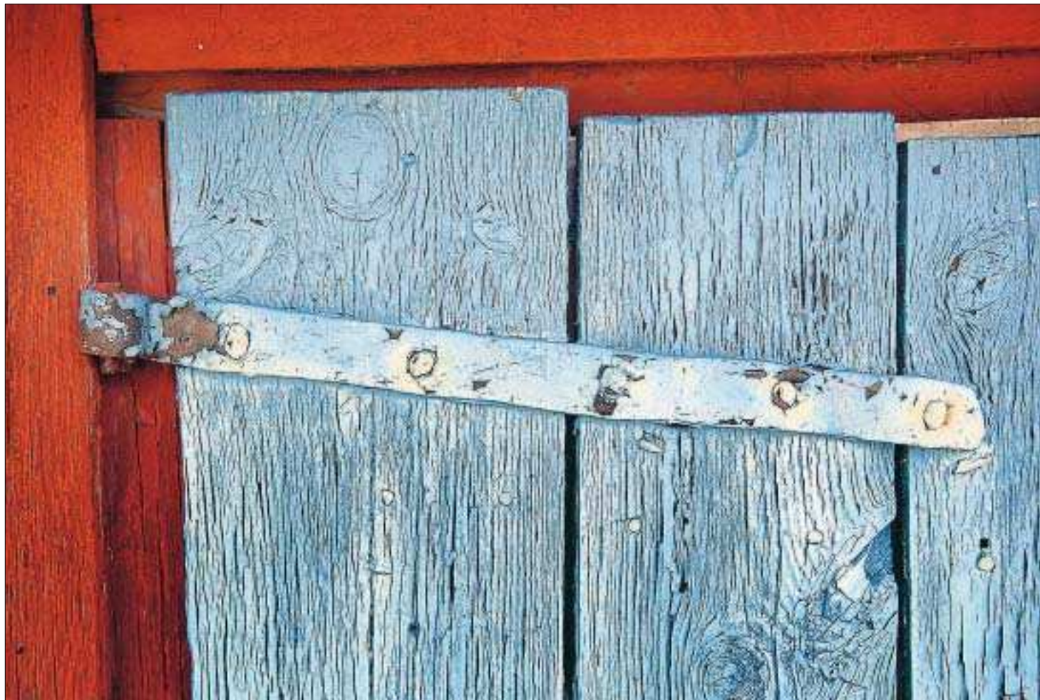
Blå dörrar. Det gamla uthuset har fint solblekta, blåa dörrar.
